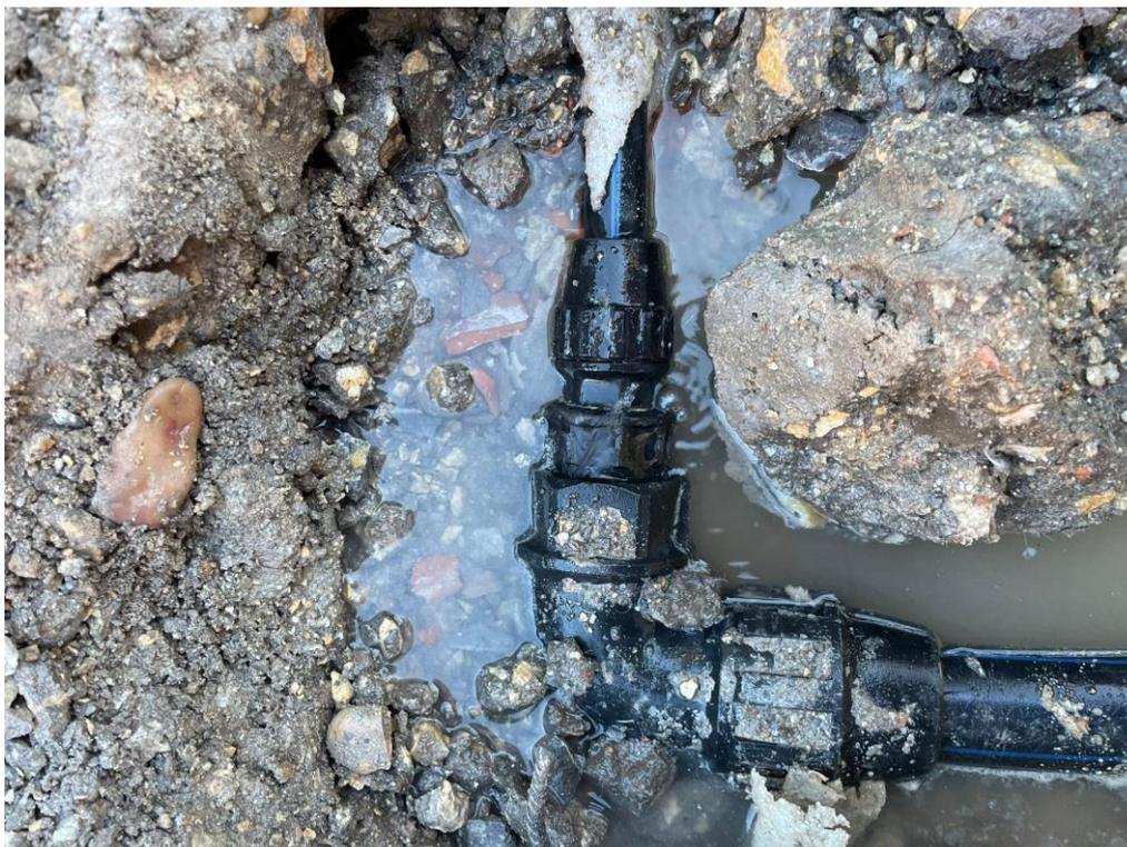
Ilustración 5 – Vista de la “T” y del codo, donde se ha localizado la rotura.
