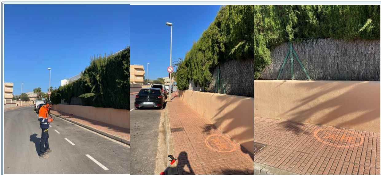
Ilustración 7 - Identificación y evaluación de la fuga [Ubicación específica de la incidencia]:
